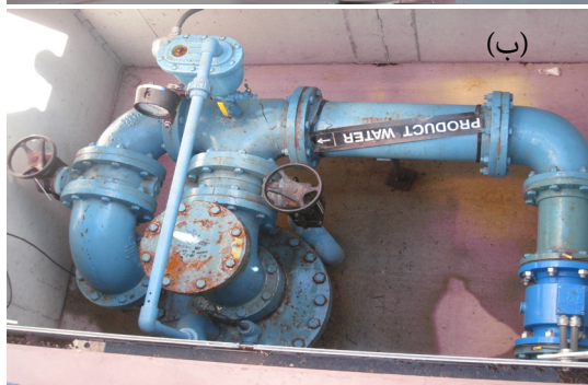
شکل ۲- الف) بخشی از تأسیسات تصفیه فاضلاب Scottsdale ب) تزریق آب تصفیه شده به سفره آب زیرزمینی
