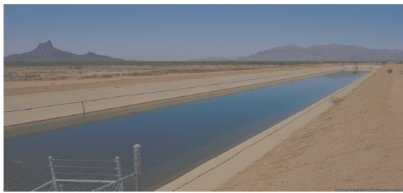
شکل ۷- بهره‌برداری و نگهداری درست از تأسیسات و کانال انتقال آب (L1)
