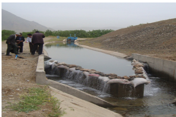
شکل ۲- دست‌کاری غیرعلمی بهره‌برداران در سازه تنظیم کننده سطح آب (I.2)
