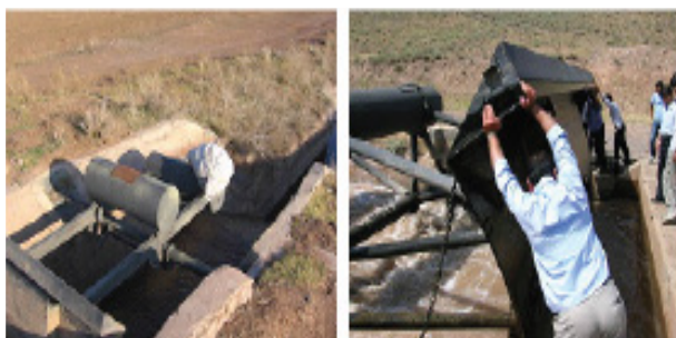
شکل ۵- دست‌کاری دریچه آمیل بر روی کانال (I.6)
