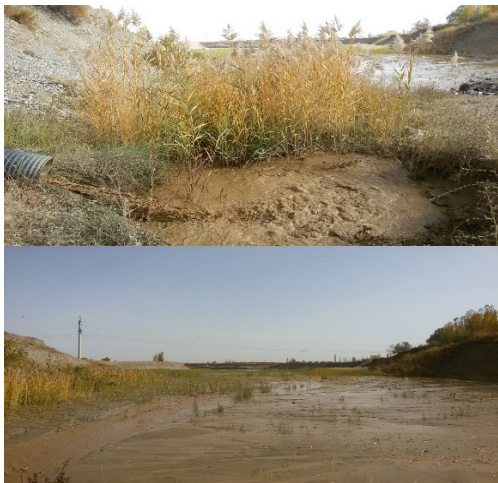
شکل ۷- سد رسوب‌گیر پساب کارگاه ماسه‌شویی نازلوچای
