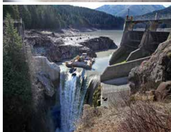
شکل ۳- سد برقابی گلین کانیون به ارتفاع ۶۴ متر، قبل از تخریب (بالا) و در حال تخریب (پائین)
