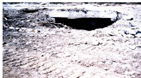
شکل ۹- تخریب پل در اثر وقوع جریان‌های غلیظ و کوچک بودن دهانه آن (مساعدی، ۱۳۸۰)
