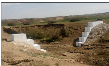
شکل ۱- احداث ایستگاه هیدرومتری شورکال درگز
