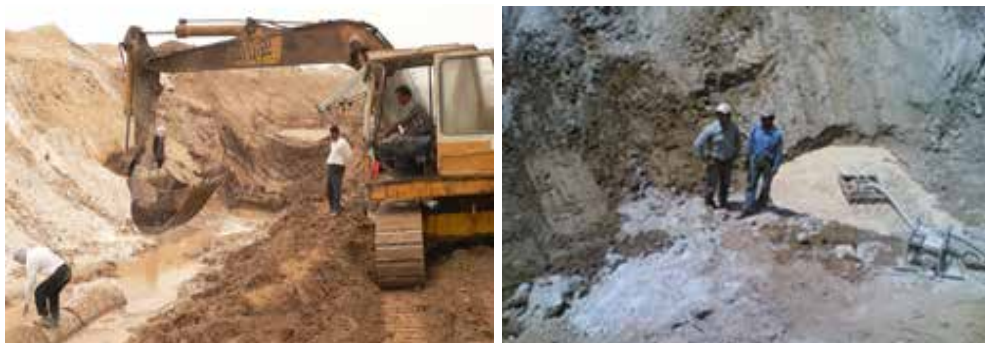
شکل ۲- عملیات پمپاژ و بیل در حال کارگذاری لوله‌های کلکتور
