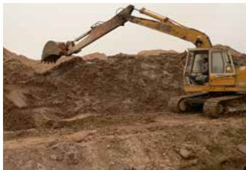
شکل ۱- بیل مکانیکی در حال انجام عملیات
