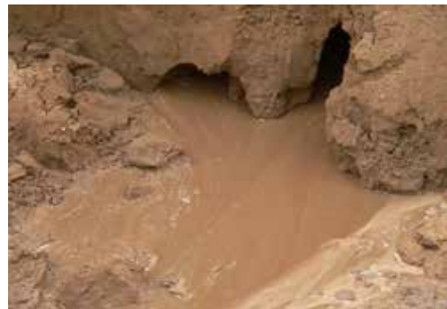
شکل ۶- حرکت ماسه از زیر دیوار جانبی و اقدام‌های اولیه جهت کنترل
