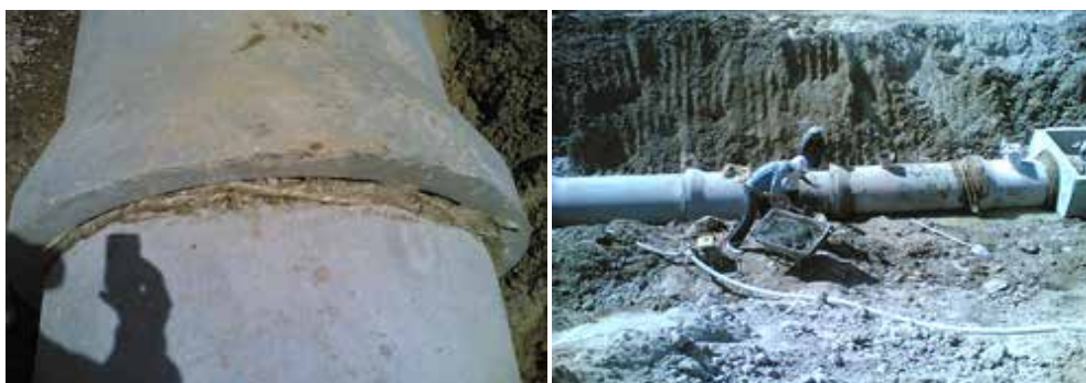
شکل ۳- کف کوبی و سیمان کردن محل اتصال لوله‌ها
