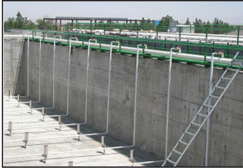
شکل ۴- شماتیک سیستم هوادهی عمقی با سوپر هواده
