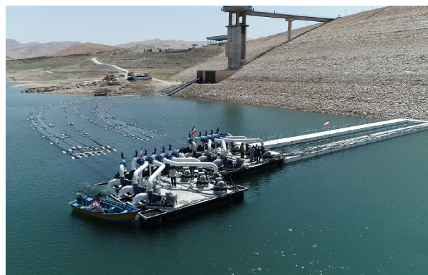
شکل ۸- ایستگاه پمپاژ شناور در حال بهره‌برداری، مرداد ۱۴۰۲
