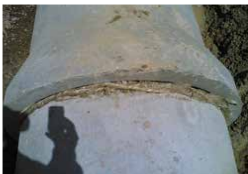
شکل ۳- کنف‌کوبی و سیمان کردن محل اتصال لوله‌ها
