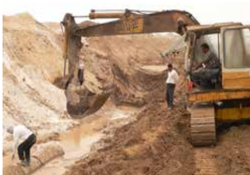
شکل ۲- عملیات پمپاژ و بیل در حال کارگذاری لوله‌های کلکتور
