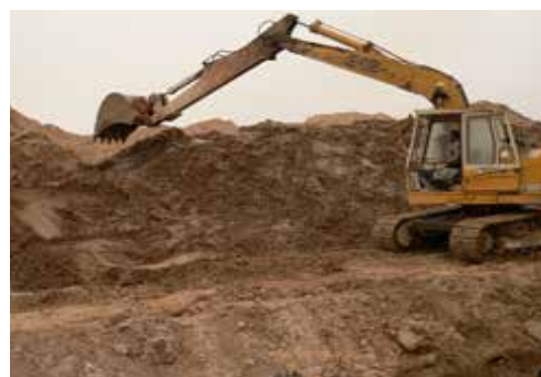
شکل ۱- بیل مکانیکی در حال انجام عملیات
