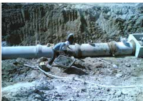
شکل ۳- کنف‌کوبی و سیمان کردن محل اتصال لوله‌ها
