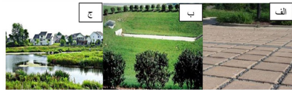
تکنیک‌های مدیریت رواناب برای خیابان‌ها و کوچه‌ها: (الف) پیاده‌رو متخلخل (ب) حوضچه نگهداشت خشک (ج) حوضچه نگهداشت مرطوب
