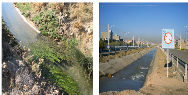
شکل ۴- عدم لایروبی کانال‌های انتقال آب به دلیل دولتی بودن و عدم مشارکت بهره‌برداران در نگهداری (L2)
