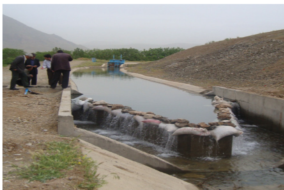
شکل ۲- دست‌کاری غیرعلمی بهره‌برداران در سازه تنظیم کننده سطح آب (L2)
