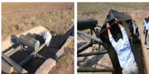
شکل ۵- دست‌کاری دریچه آمیل بر روی کانال (L6)
