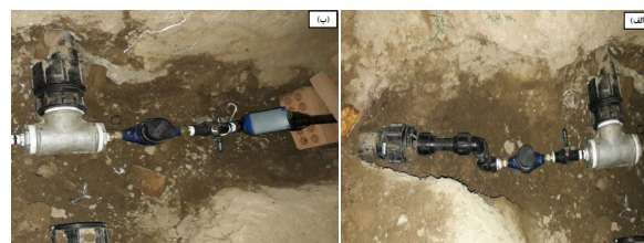
شکل ۲- سامانه آبیاری هوشمند (الف)، سامانه آبیاری دستی (ب)
