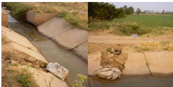
شکل ۳- شکستن کانال انتقال آب جهت بهره‌برداری (L1)
