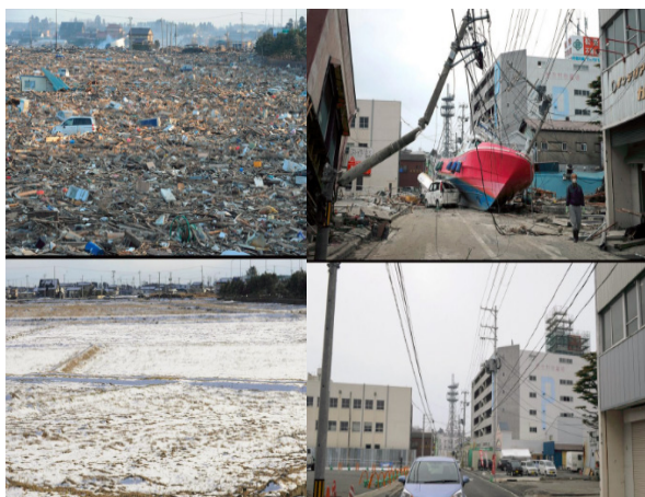
شکل ۴- عکس‌های بالاپس از رخداد زلزله و سونامی در فوکوشیما و عکس‌های پایین پس از انجام پاک‌سازی و بازسازی خرابی‌ها
