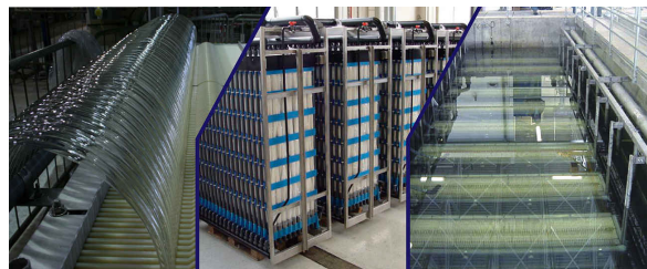
شکل ۱- نمونه‌ای از بیوراکتور غشایی مورد استفاده در تصفیه فاضلاب
