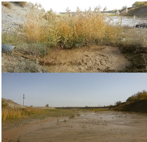
شکل ۷- سد رسوب‌گیر پساب کارگاه ماسه شویی نازلوچای
