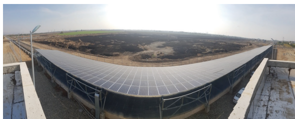
شکل ۳- نصب پنل‌ها روی کانال فاضلاب و امتداد در مسیر آن در نیروگاه ۴۰۰ کیلوواتی تصفیه‌خانه جنوب تهران (راه‌اندازی نیروگاه خورشیدی در تصفیه‌خانه فاضلاب جنوب تهران، ۱۳۹۷)
