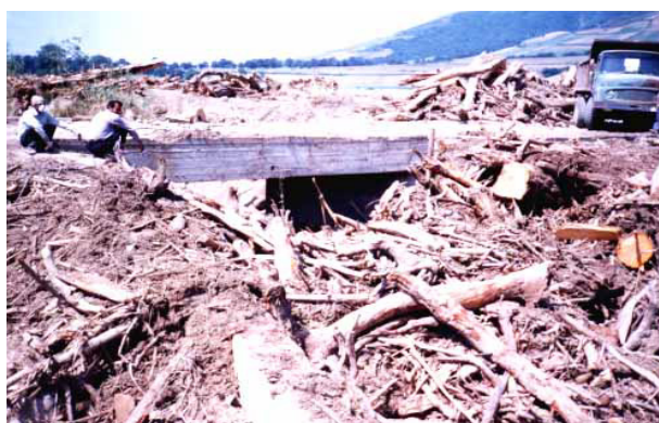
شکل ۱۱- مسدود شدن دهانه‌های پل به وسیله تنه درختان در جنگل گلستان و در نتیجه تشدید خسارات سیل (مساعدی، ۱۳۸۰)
