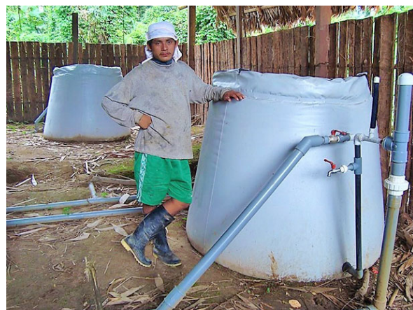
الف- فیلتر شنی کُند در مقیاس کوچک، ساخته شده از پلاستیک واقع در کنیا
